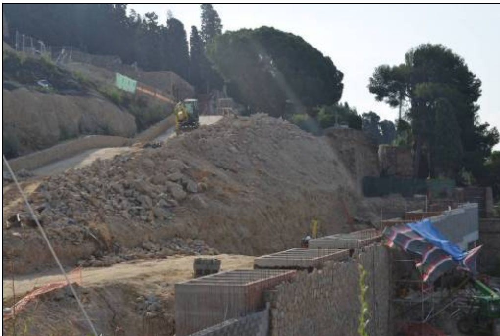
Foto 7: Construcció de nínxols a l'àrea afectada de la muntanya de Montjuïc.
