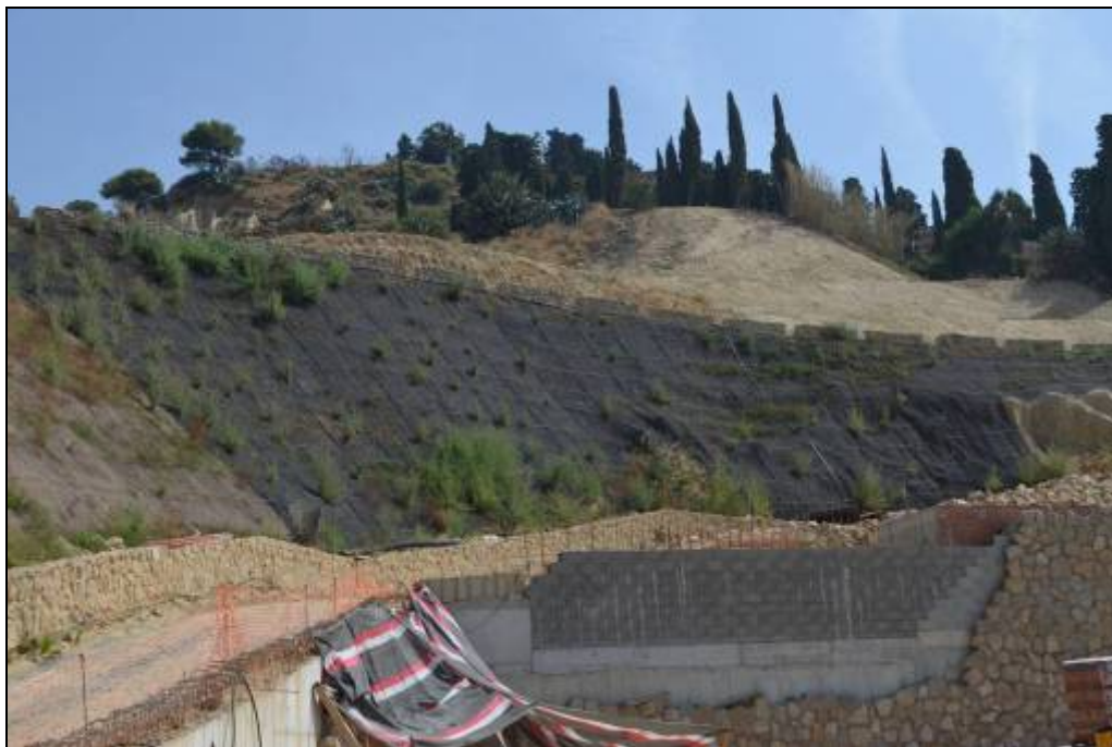
Foto 13: Vista general de l'obra constructiva. A la part inferior amb la malla per evitar esllavissament, i part superior que correspon als rebaixos efectuats en la darrera modificació del vessant de la muntanya.
