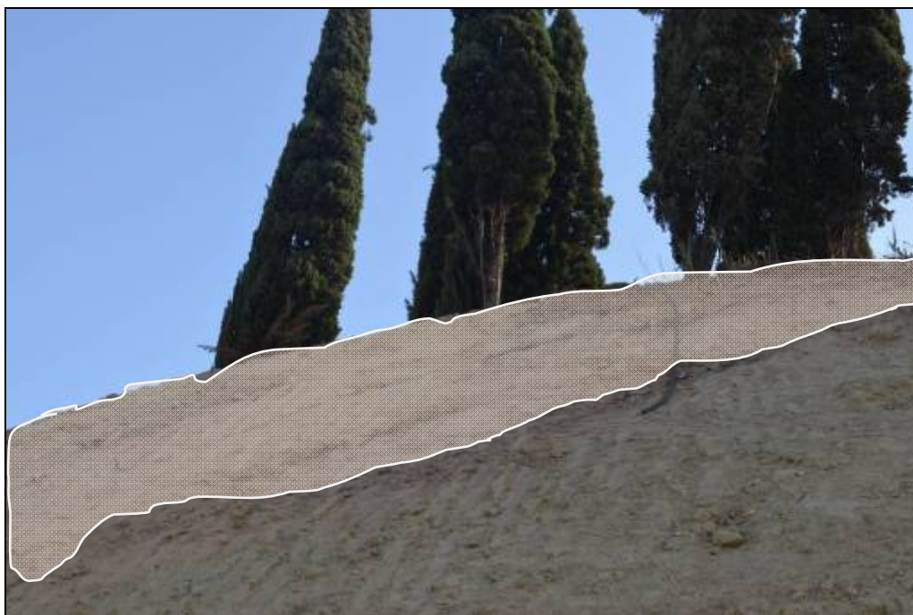
Foto 6: Punt més alt afectat on es pot veure les restes de material aportat a la construcció del Cementiri de Montjuïc. Àrea marcada en la imatge correspon al rebliment del segle XIX.
