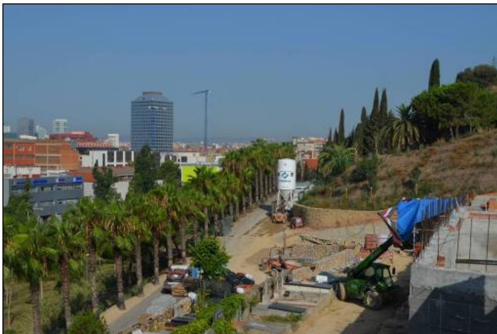
Foto 8: Vista general de l'obra constructiva.
