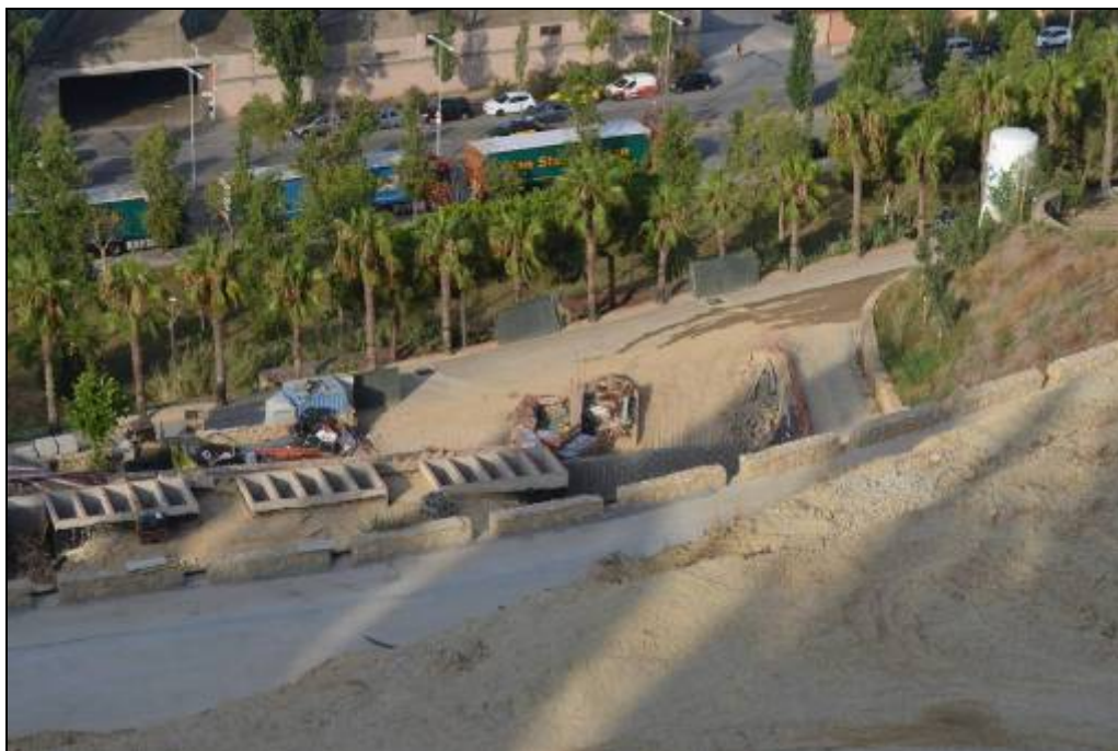
Foto 3: Detall de l'obra constructiva des del seu punt més alt.
