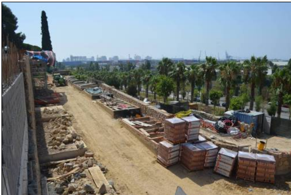
Foto 11: Vista general de l'obra constructiva amb els nínxols construint-se.
