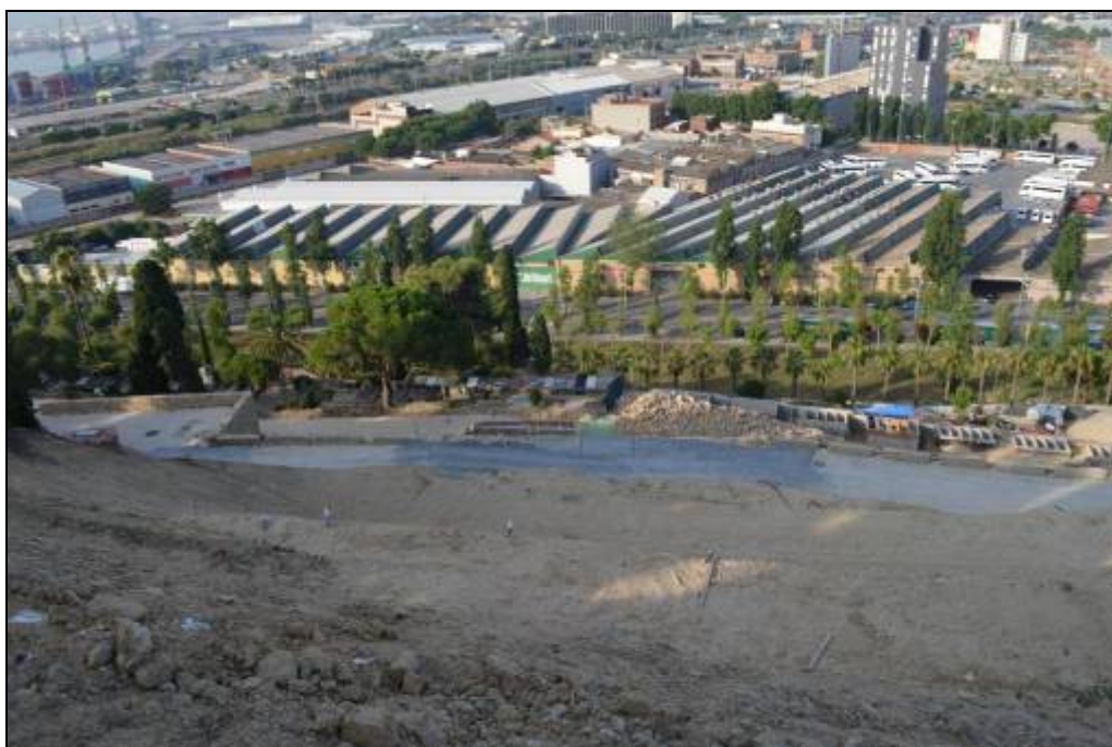
Foto 4: Vista dels rebaixos efectuats en el vessant afectat per l'esllavissament.
