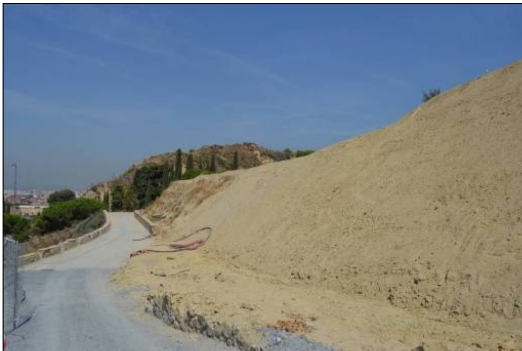
Foto 9: Vista de l'àrea afectada per l'esllavissament amb la vista del terreny format per detritus.
